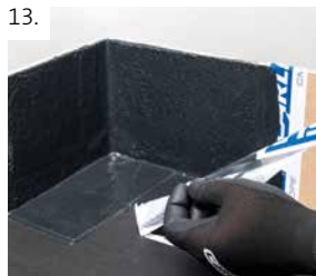
Klebeband abziehen
