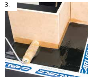
Fläche gemäß Grundierungsempfehlung behandeln. Hier LIQUISEAL® Primer auf RESITRIX® bzw. HERTALAN® Abdichtungen auftragen, Klebeband abziehen
