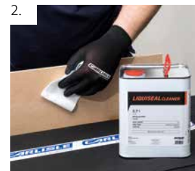
Den Untergrund reinigen, ggf. anrauen
