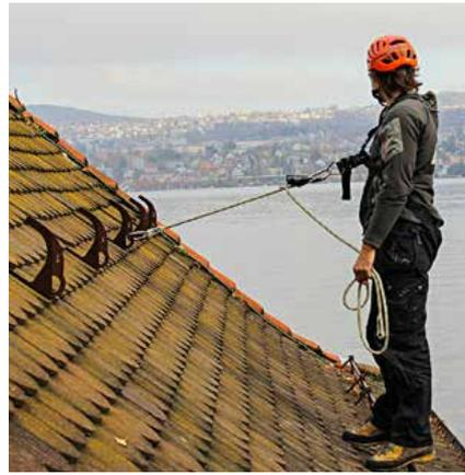
**Crochet pour toit en pente** (EN 795, EN 517)
